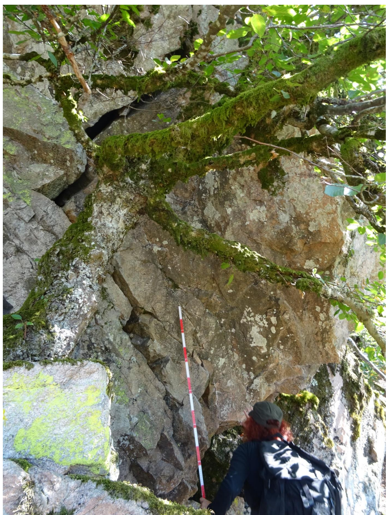
Foto 3: Gefährdungspunkt G112: Kluftkeil ca. 6 m 3 , stark vorbewegt, Trennflächen steil talwärts bis 10 cm geöffnet, Schwerpunkt überhängend, kein Fuß; Blickrichtung: NE
