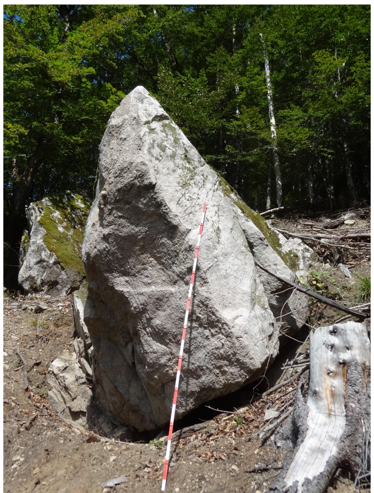
Foto 1: Gefährdungspunkt G010: 2 Blöcke, jeweils ca. 15–20 m 3 ; Trennflächen hangausfallend, hohl liegend, 10 cm vorbewegt; Blickrichtung: NE
