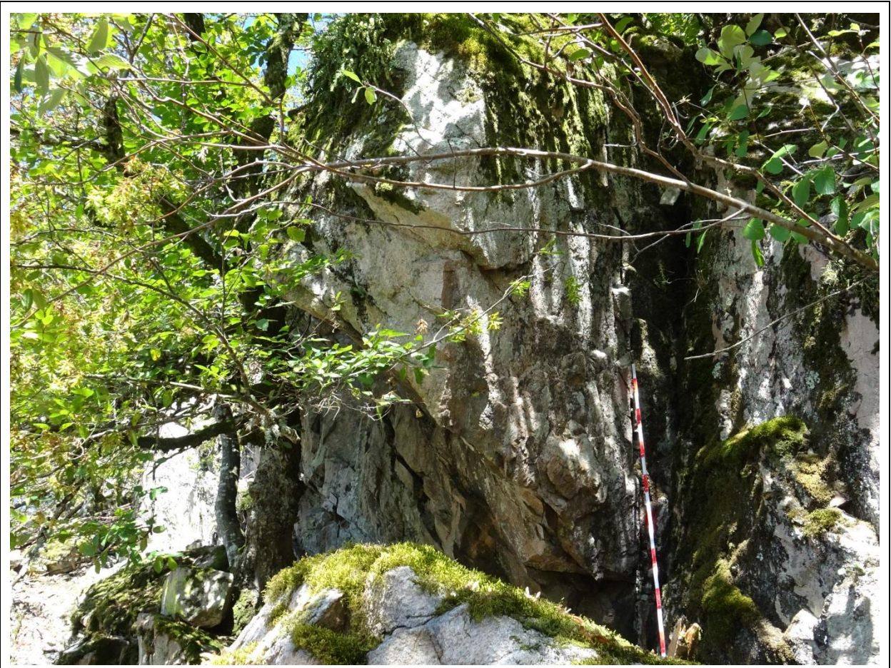
Foto 4: Gefährdungspunkt G112; Blickrichtung: NW
