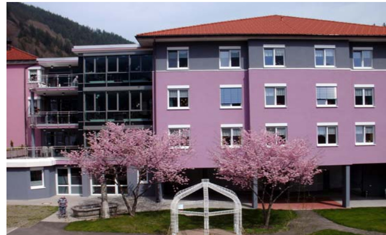
Städtisches Alten- und Pflegeheim Todtnau - nach dem Umbau und der Erweiterung in den Jahren 2007 bis 2009 -
