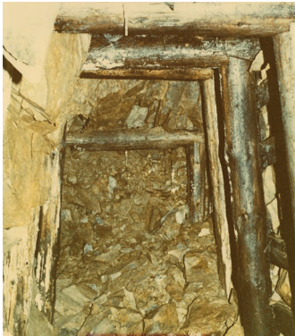
Verstärkter Stollen am Silberberg
