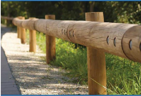
Bild 1 + 2: Holzleitplanke „Lignum-Rail®“ von Volkmann und Rossbach®
