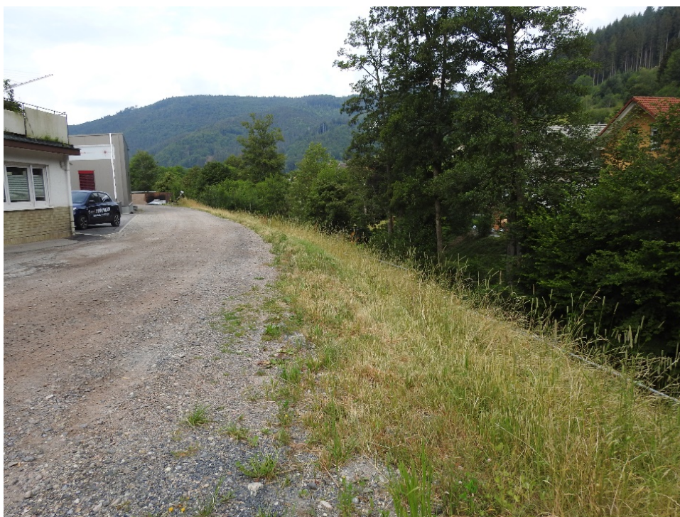
Abbildung 4: Straßenbereich, der saniert werden soll.
