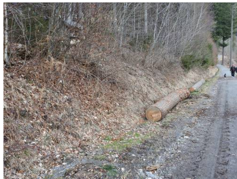
Abbildung 5: Graben im westlichen Eingriffsbereich (Foto Frühjahr 2018)
