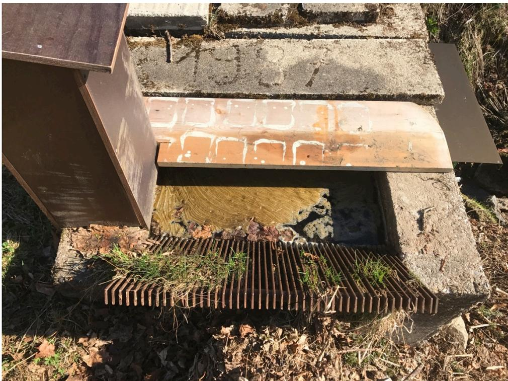
**Abbildung 20:** Bestehender Feinrechen am Übergang Oberwasserkanal / Druckrohrleitung
