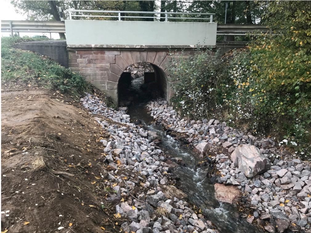
**Abbildung 21:** Umgehungsgerinne mit ähnlicher Beaufschlagung, Blick gegen die Fließrichtung
