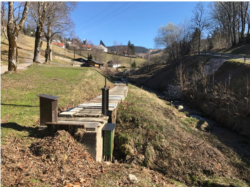
**Abbildung 14:** Vorhandener Zulaufkanal mit Spülschütz und Grobrechen, Blick entgegen der Fließrichtung
