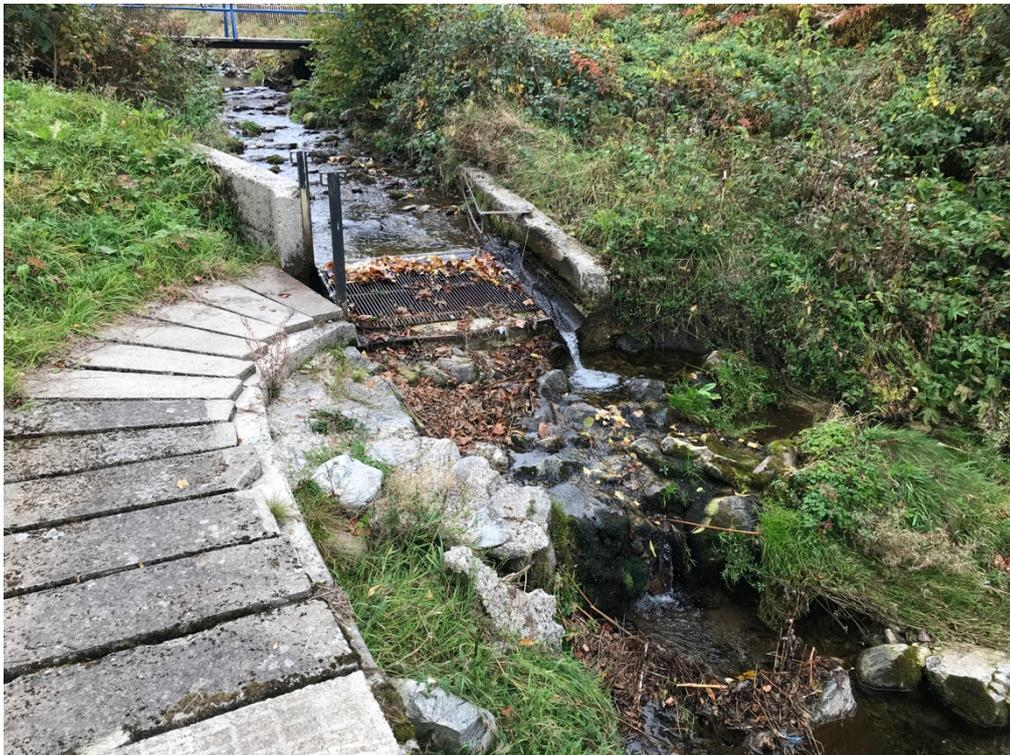
**Abbildung 10:** Vorhandenes Tiroler Wehr, Fließrichtung von links nach rechts
