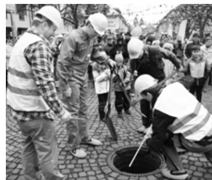
Der Bautruppschon mal los auf dem Marktplatz
