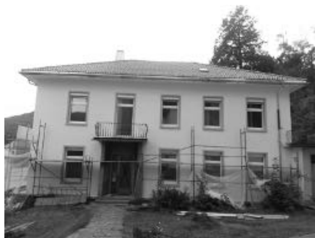
Pfarrhausrenovierung in Todtnau
