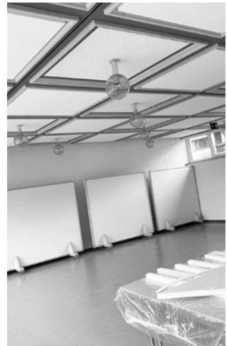
Präzise wurden die Dämmelemente passgenau eingesetzt, die Klebepistole wurde oft geladen, das Resultat ist ein Erfolg!
