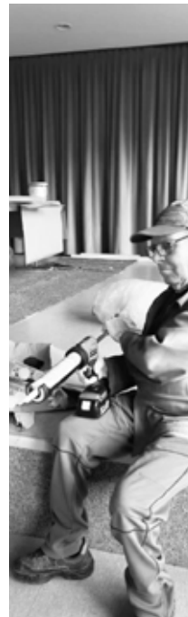
Präzise wurden die Dämmelemente passgenau eingesetzt, die Klebepistole wurde oft geladen, das Resultat ist ein Erfolg!
