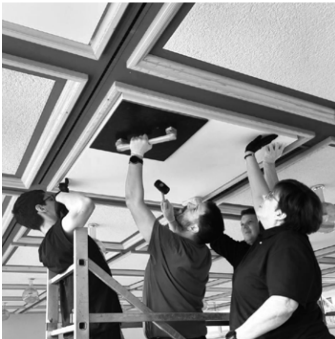
Präzise wurden die Dämmelemente passgenau eingesetzt, die Klebepistole wurde oft geladen, das Resultat ist ein Erfolg!
