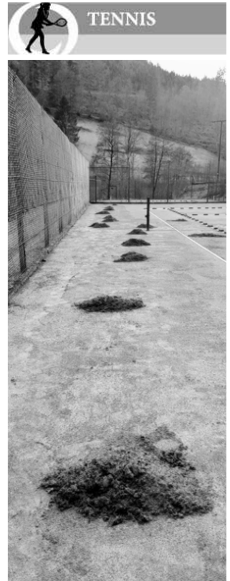
Was auf den ersten Blick aussieht, als hätte es eine Invasion von Maulwürfen gegeben, sind nur die Vorboten der Platzaufbereitung mit rotem Sand
